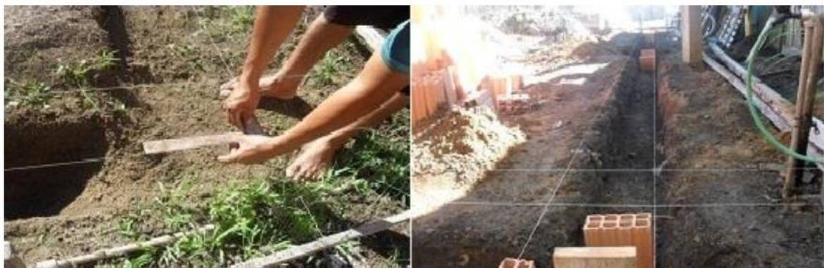
Figura 3 – Esquadreamento de uma casa
