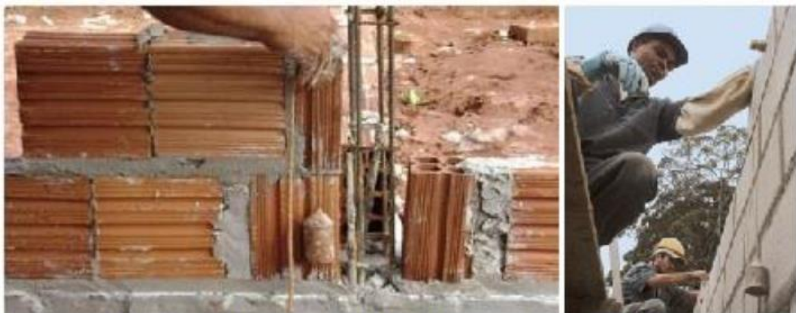
Figura 7 – Utilização do prumo na construção civil
