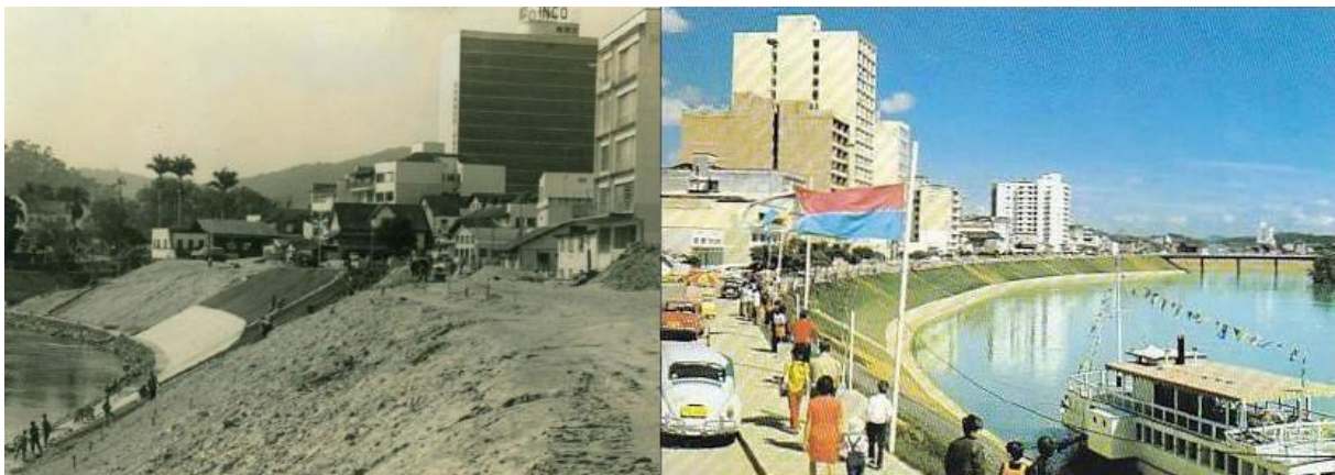
Figura 2 - Construção da Avenida Beira-Rio e a nova relação da cidade com o rio. Fonte: AHJFS, s/d.
