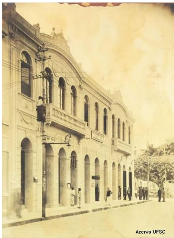
Figura 2: Fotografia do Prédio onde funcionou a Faculdade de Direito de Santa Catarina, 1932
