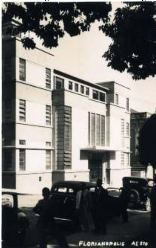
Figura 3 - Fotografia do Prédio da Agência dos Correios e Telégrafos de Florianópolis. 1937
